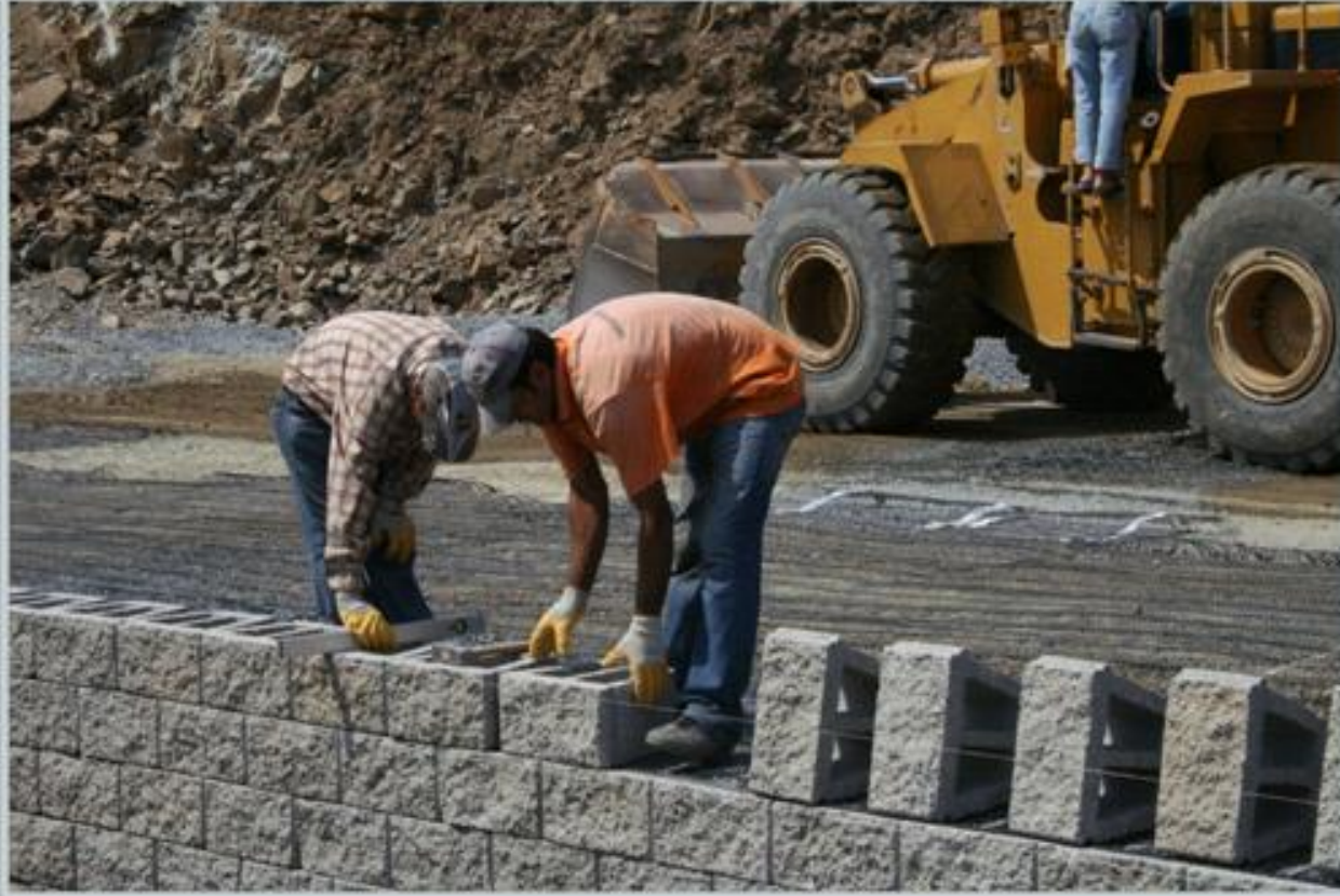
Yapıbloklar yerleştirilir
