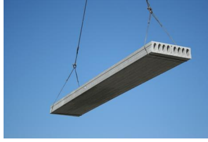
Şekil 7: Mesnetlerinden tutularak kaldırılan Panelton
