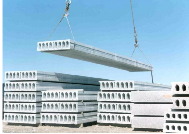
Şekil 1 : Panelton, öngerilmeli boşluklu döşeme elemanı
